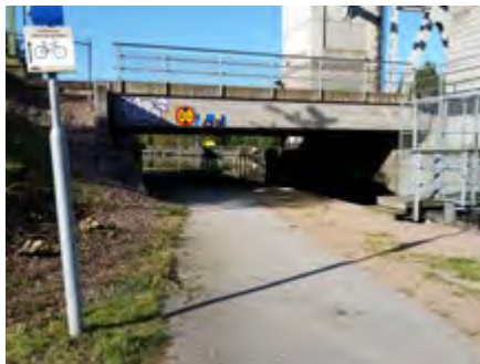
Tunnel vid järnvägsbrons östra brofäste
