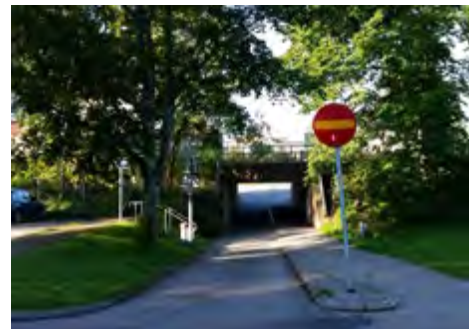
Tunnel mellan Storgatan - Parkstigen
