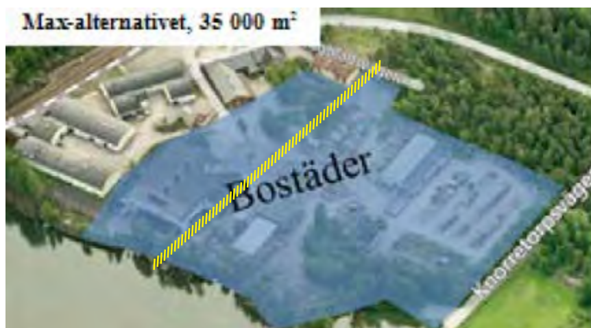
Saneringsområde MAX enligt utredningen "Hantering av förorenad mark och byggnader". Markerat område är det som bedöms vara mest förorenat och som fyllts ut med förorenade massor.
