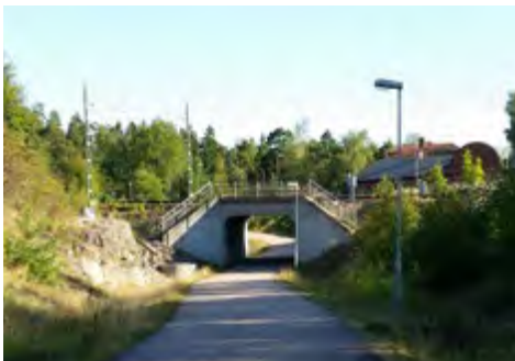
Tunnel söder om Stridsberg & Biörck
