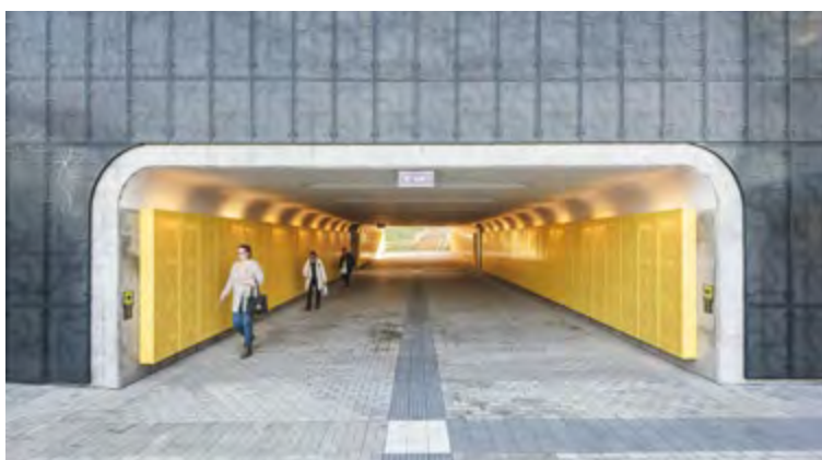
Referensprojekt från Nykvarns station. Arbete utfört av SWECO och foto av Ernst Henry
